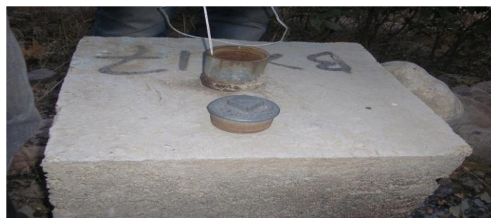
شکل ۳. تصویر کلی یک پیزومتر
